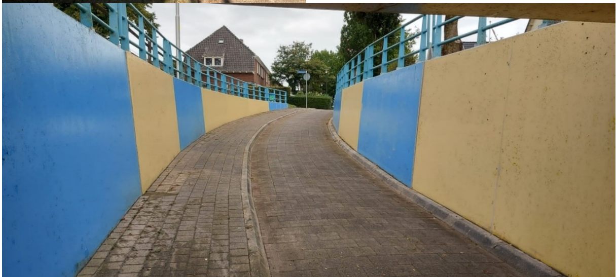
Oude Doetinchemseweg Zeddam, situatie tunnel voor en na reiniging
