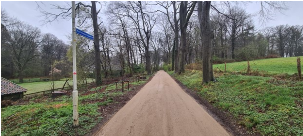
Nachtegaalslaantje en Stokkum, nadat Padvast is aangebracht.
